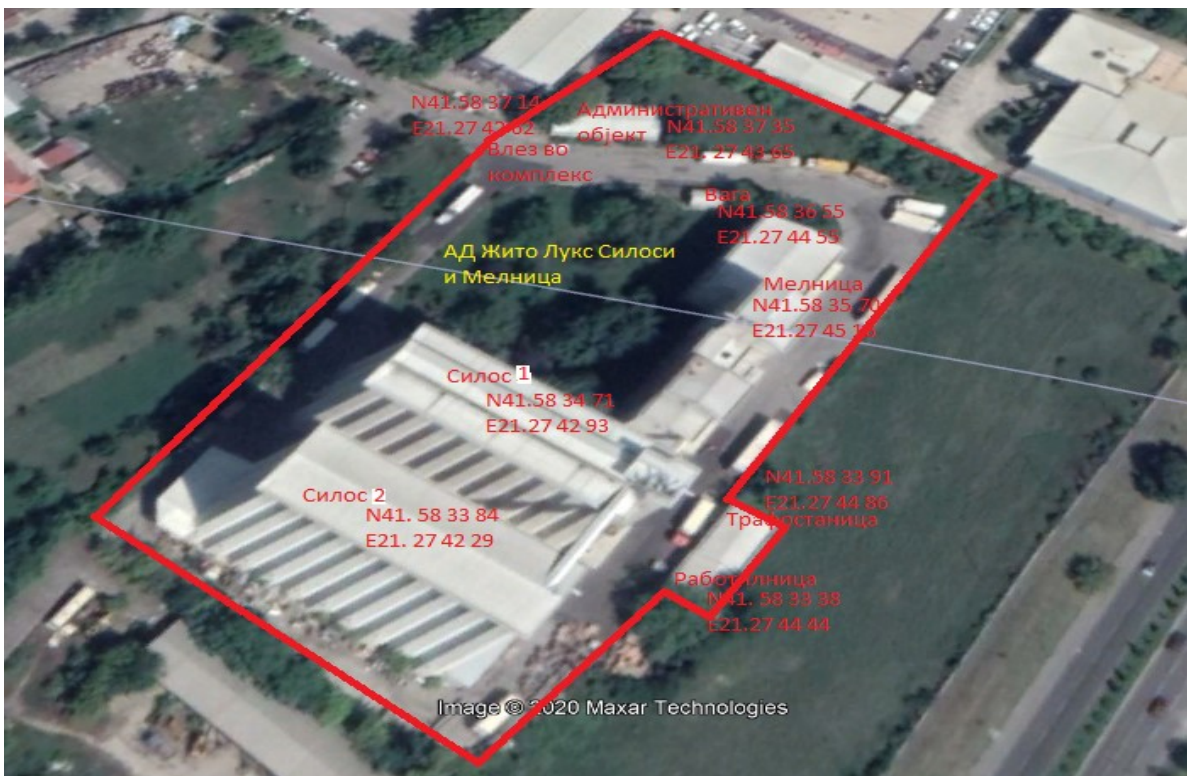
микро локацијата и сателитска снимка од микролокацијата на индустриски комплекс-Силоси и Мелница
