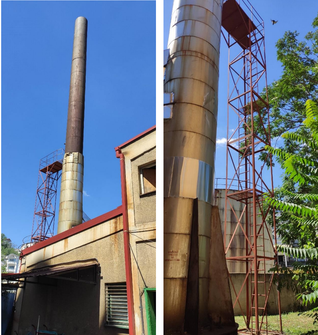
Слика бр.12: Испусти од котли
