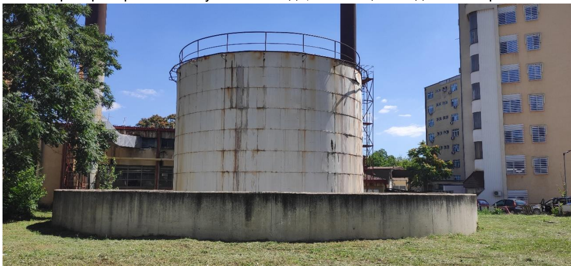
Слика бр. 1: Надземен резервоар за мазут
