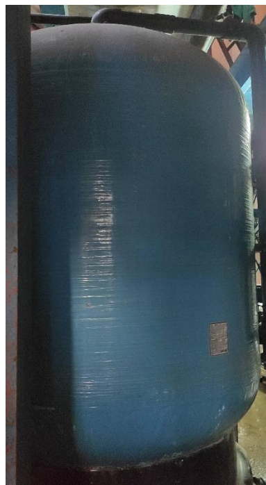
Слика бр. 2 - 2 резервоари за омекнување на вода
