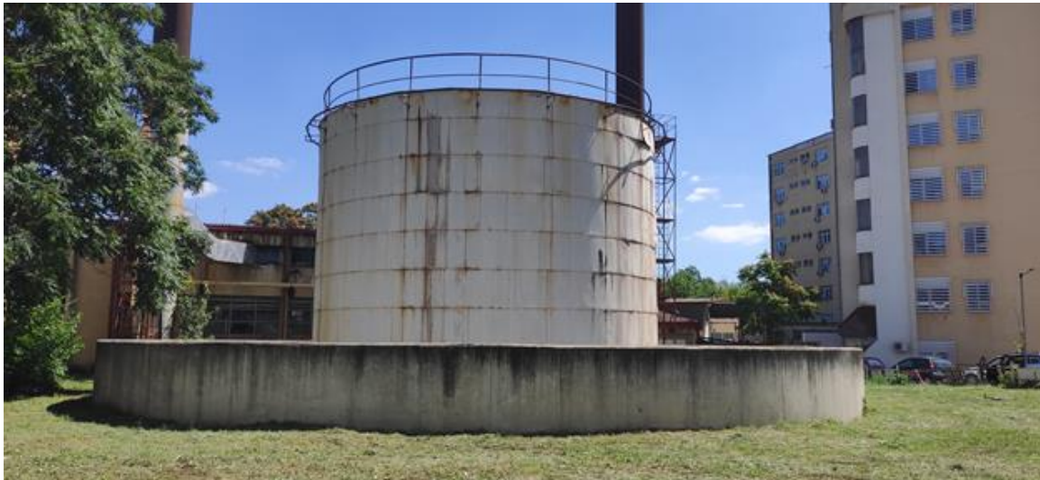
Слика бр. 14: Надземен резервоар за мазут
