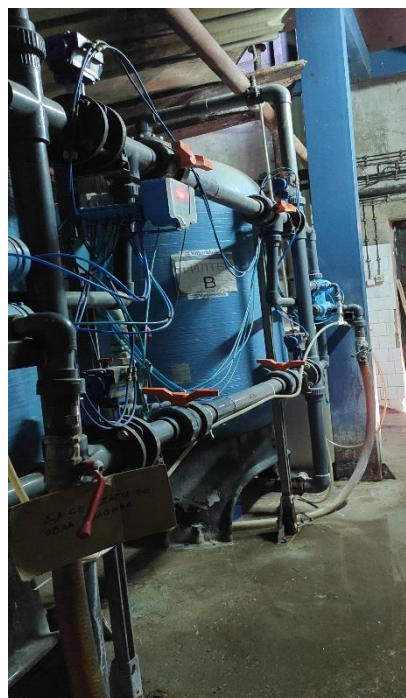
Слика бр. 2 - 2 резервоари за омекнување на вода
