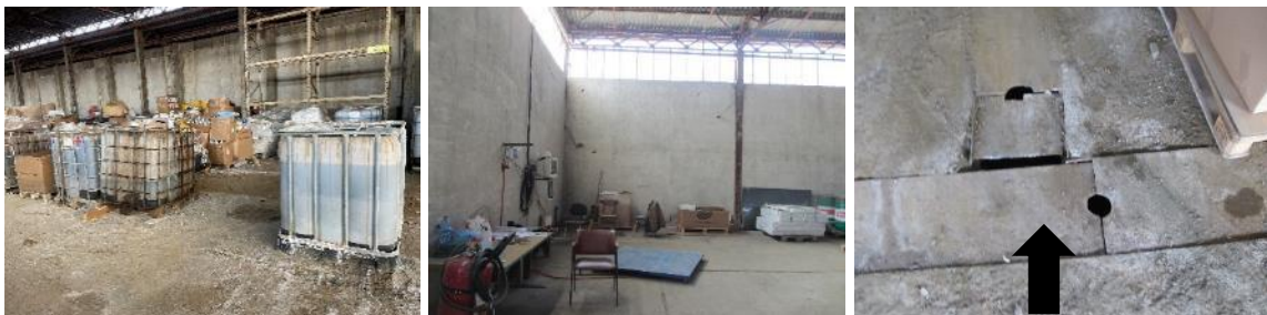
Канал за одведување на можни истекувања од складираниот отпад
