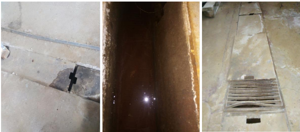
Слика 2 Канал за можни испусти во рамки на складиштето на компанијата “ЕЗО – ТЕХ”
