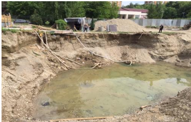
Слика 21 Појава на подземни води на градилиште во I или II заштитна зона на Лепенец (фото: Ј.Милевски)
