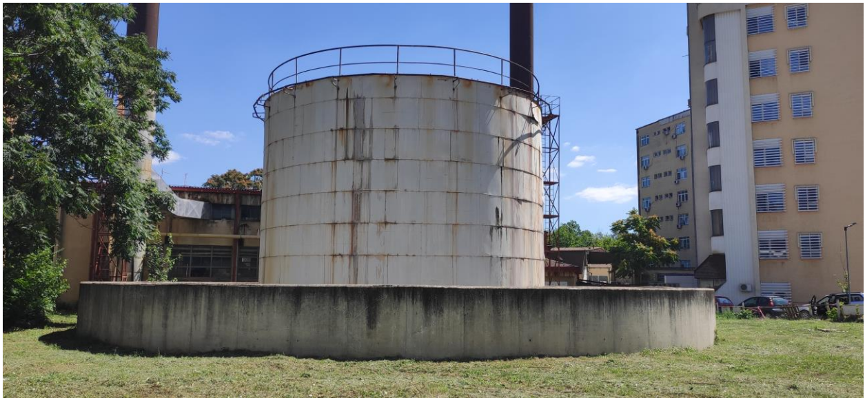
Слика бр. 13: Надземен резервоар за мазут
