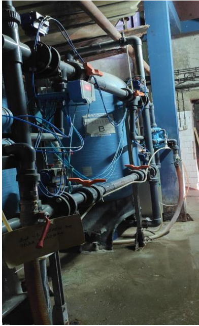
Слика бр. 26: 2 резервоари за омекнување на вода
