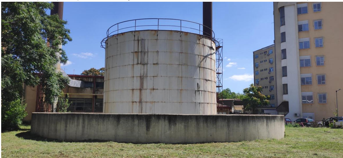
Слика бр. 25: Надземен резервоар за мазут
