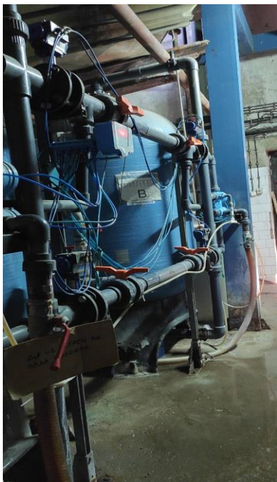
Слика бр. 16: 2 резервоари за омекнување на вода
