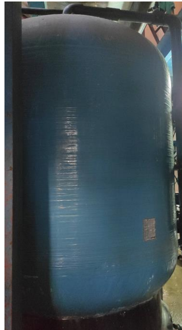
Слика бр. 16: 2 резервоари за омекнување на вода
