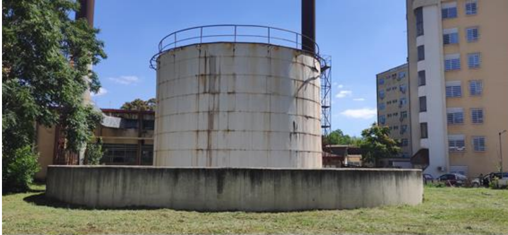
Слика бр. 15: Надземен резервоар за мазут
