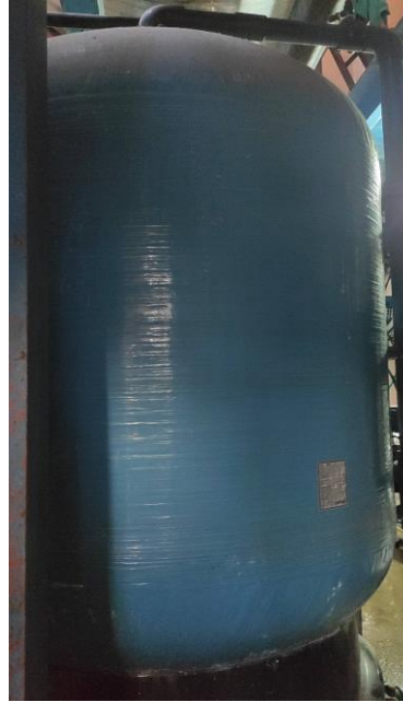
Слика бр. 26: 2 резервоари за омекнување на вода
