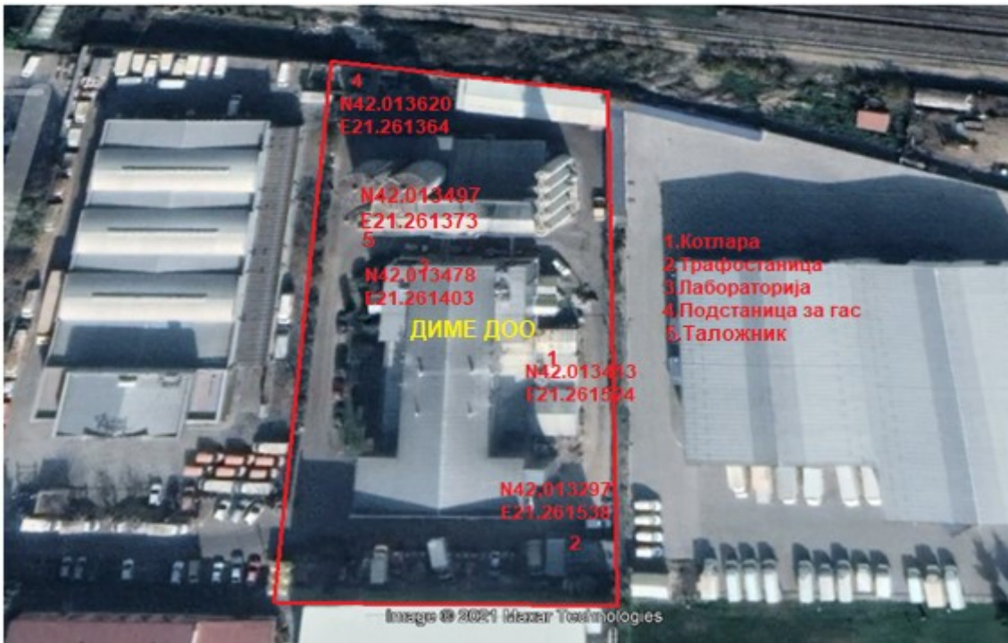
Сателитска снимка на локација на котлара, подстанција за природен гас, трафостаница, лабораторија и таложник
