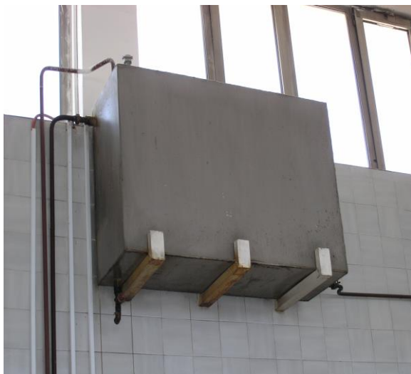
Слика 11. Дневен резервоар за нафта
