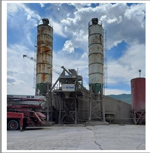
Слика бр. II.2-3: Стара бетонера
