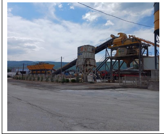
Слика бр. II.2-4: Нова бетонера
