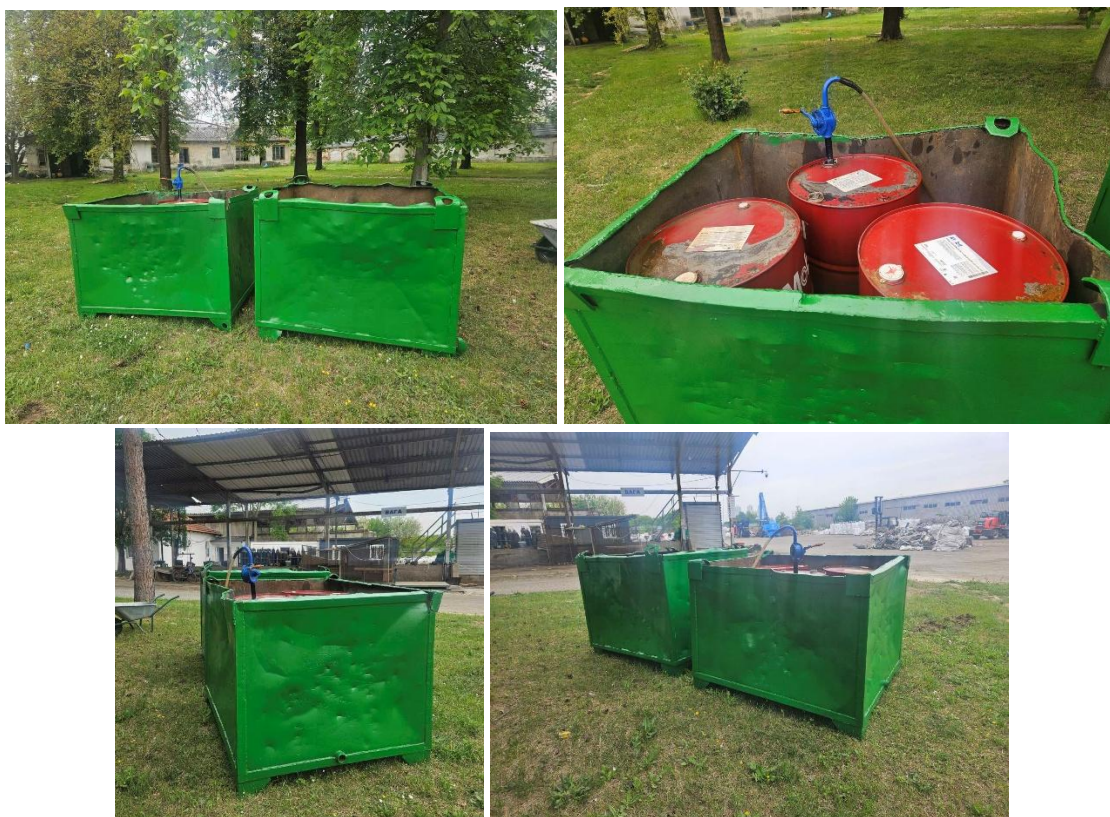
Слика 2 Приказ на кадите за задржување при евентуално истекување на моторни масла во инсталацијата “РЕЦКОСС – ТРАНС” ЛТД ДООЕЛ Скопје – Подружница 3 - Скопје
