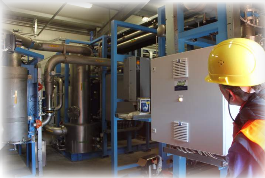
Надградба за биогаз со технологија со мембрана за постројката за биогаз AVA (Извор: D. Rutz, WIP)
