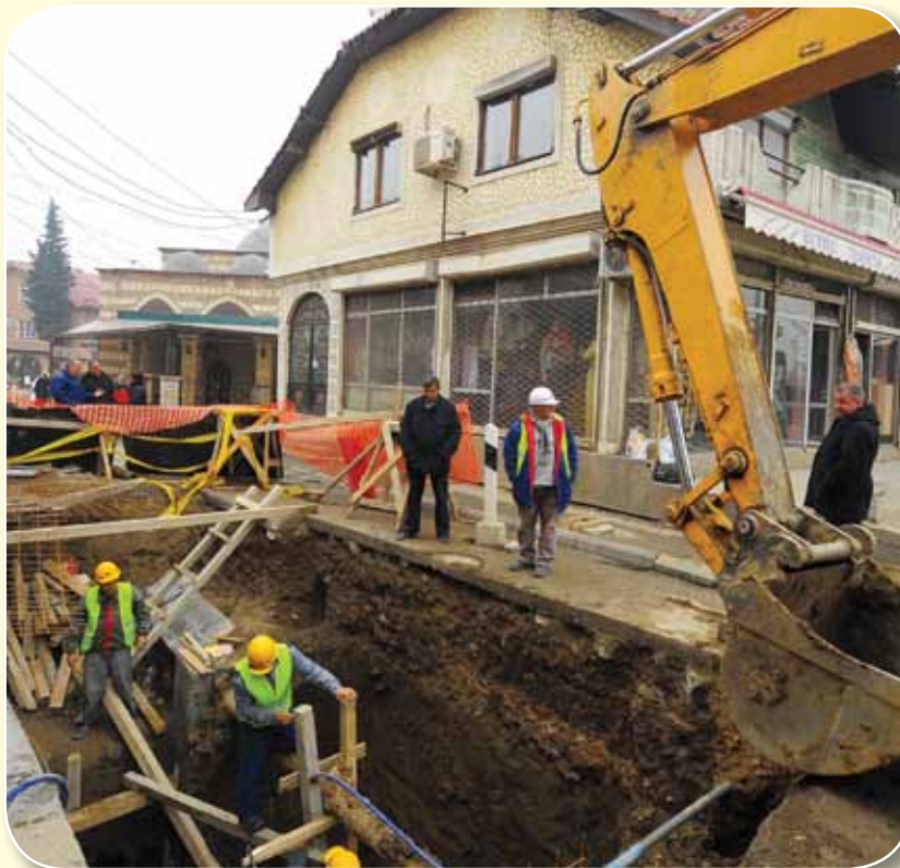
Kanalizim atmosferik në BV "Bajram Shabani"
