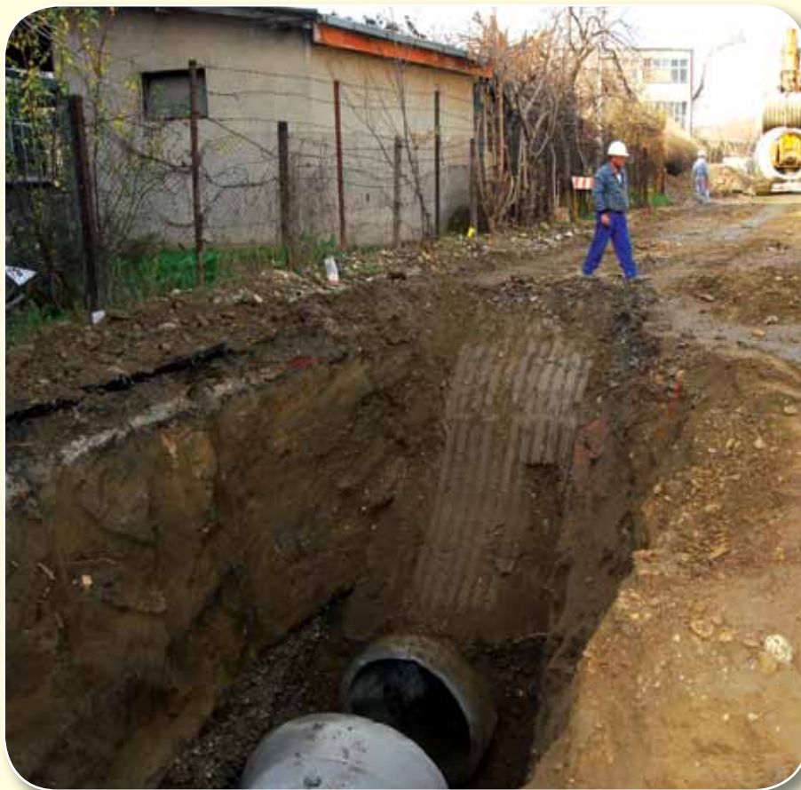
Kanalizim atmosferik në Qeramidnica
