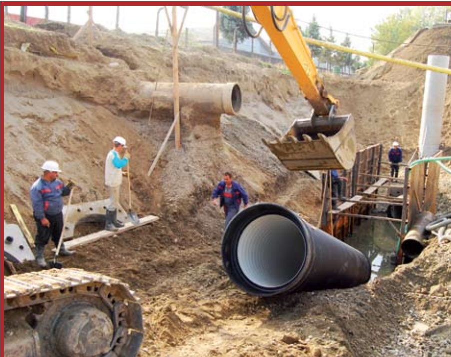
Изградба на фекалната канализација во Инџиково
