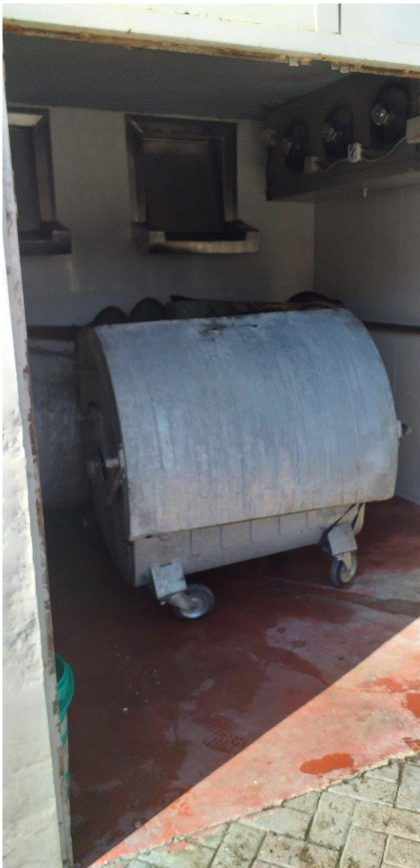
Просторија за отпад со збирни контејнери, обезбедена со систем за ладење
